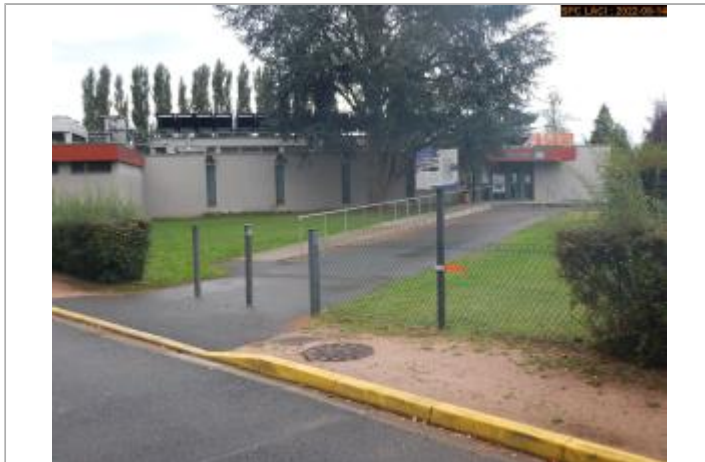
Vue du site éloignée
