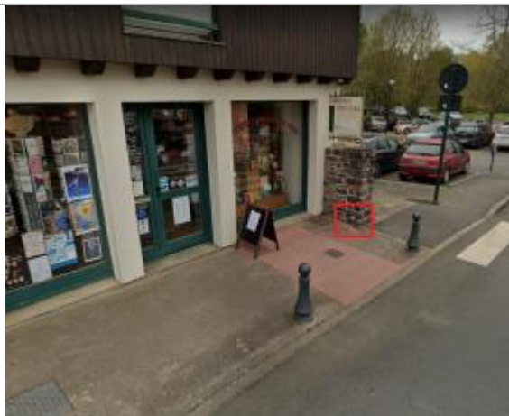
muret au 6 rue des arcades en 2022
