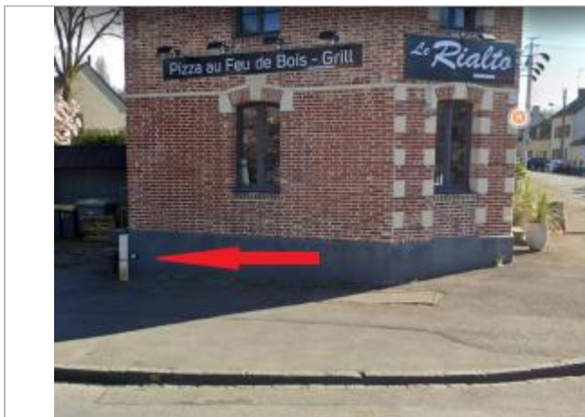
Pignon d'un bâtiment - restaurant en 2022
