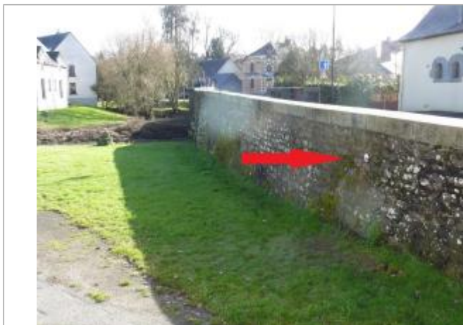
muret de protection rue du Dct Léon
