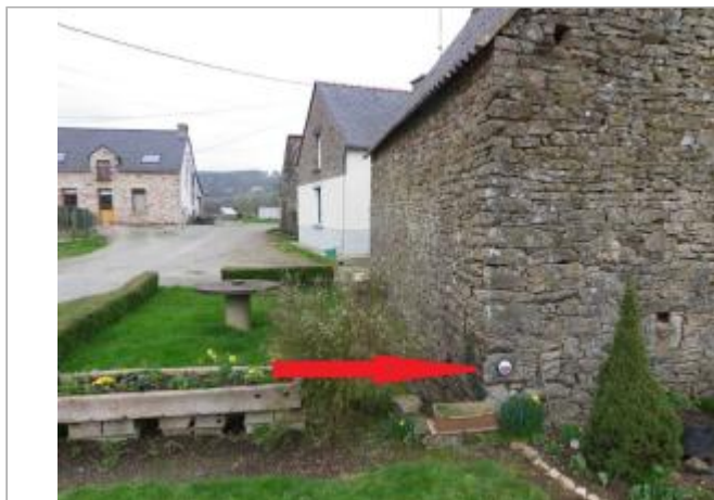
Bâtiment au lieu-dit "Le Prazé" en 2011
