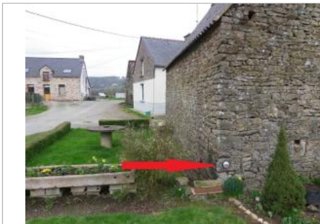
Bâtiment au lieu-dit "Le Prazé" en 2011
