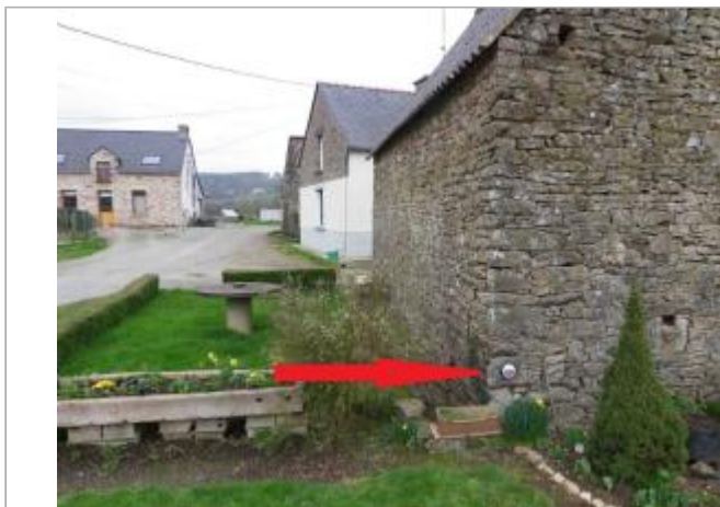
Bâtiment au lieu-dit "Le Prazé" en 2011
