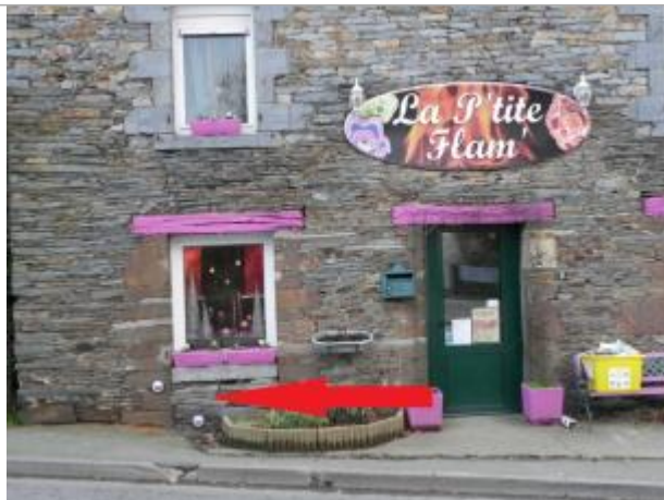
Bâtiment commercial en 2011
