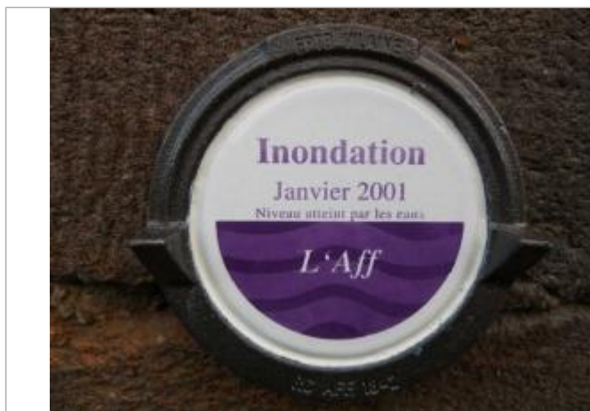
Repère normalisé de l'inondation de janvier 2001
