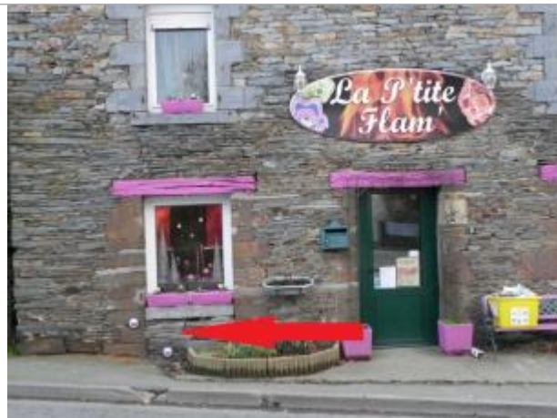
Bâtiment commercial en 2011
