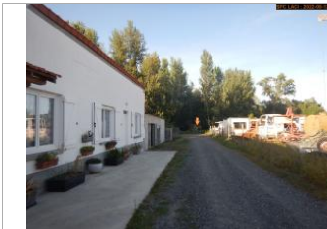
Vue du site éloignée
