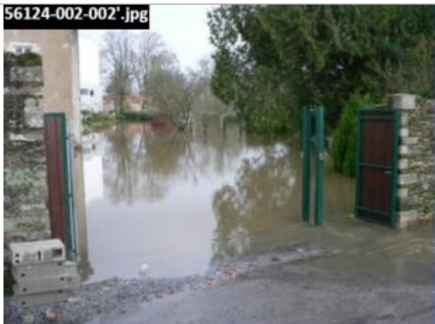
Inondation du 8 février 2014 - photo services techniques de la ville de Malestroit
