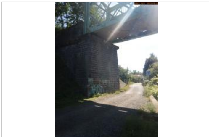
Vue du site éloignée (côté aval)
