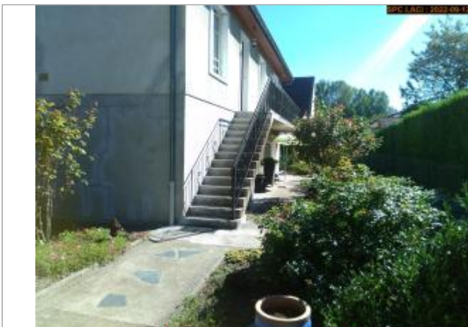
Vue du site éloignée
