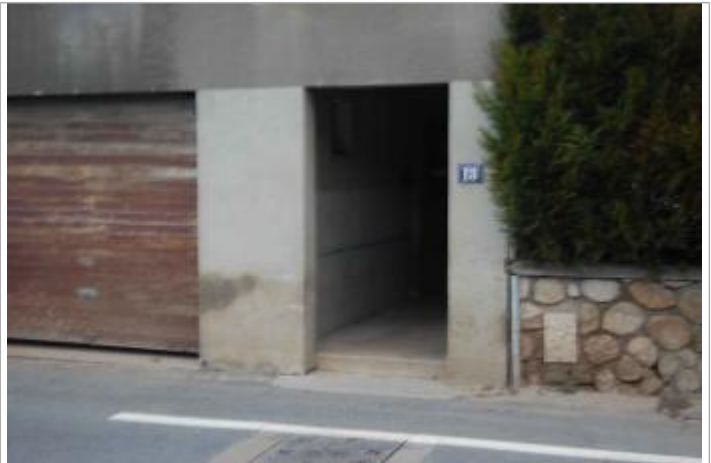
Vue du site - Auteur : GEOSPHAIR
