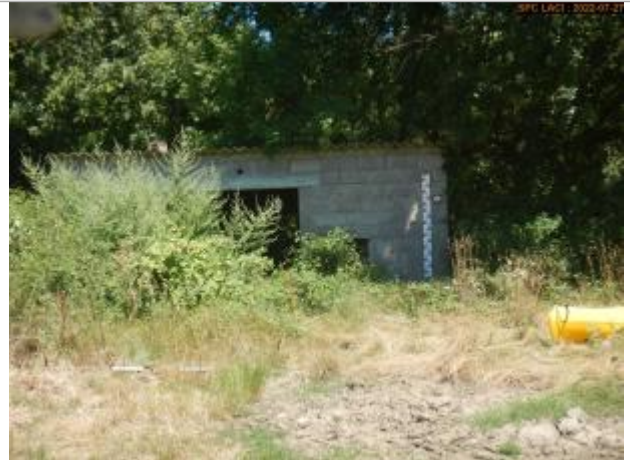
Vue du site éloignée
