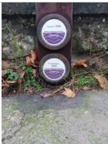
Repère de crue 2008 - poteau en fer côté trottoir
