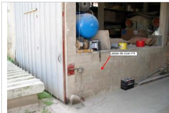
Mur à gauche dans l'entrée du moulin (en activité en 2004)
