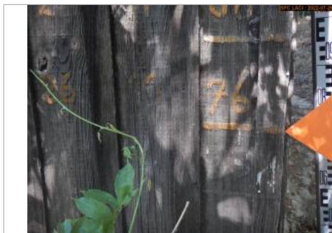
Vue du repère (face côté gauche)
