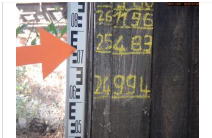
Vue du repère (face côté Allier)
