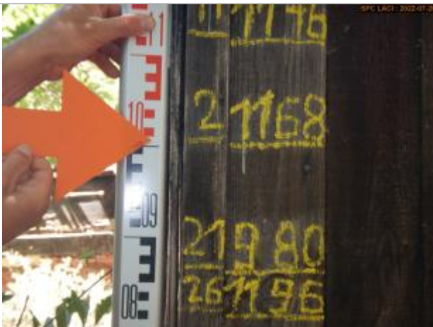
Vue du repère (face côté Allier)
