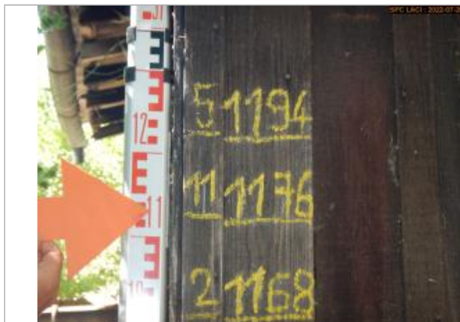
Vue du repère (face côté Allier)
