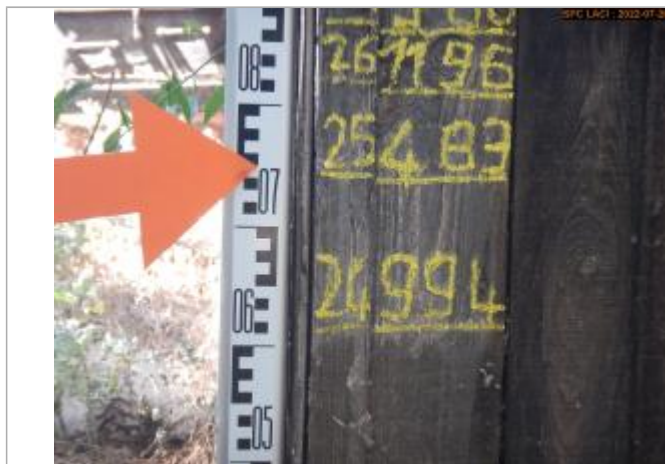
Vue du repère (face côté Allier)
