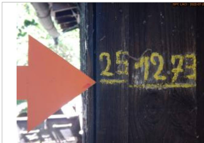
Vue du repère (côté Allier)
