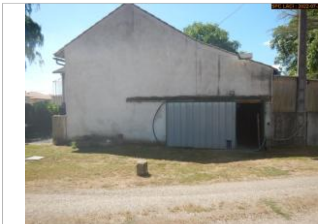
Vue du site éloignée
