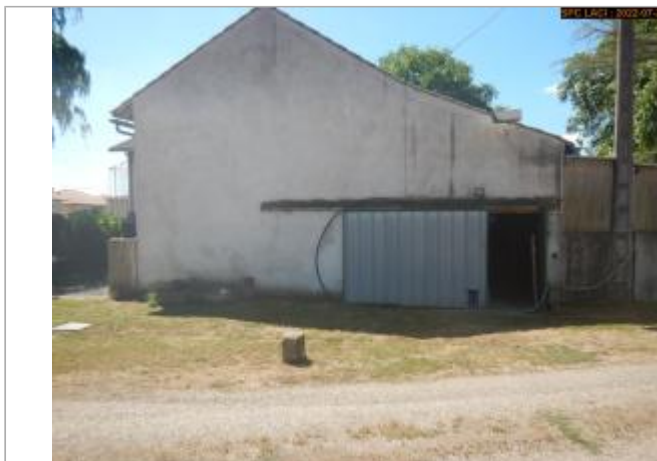
Vue du site éloignée
