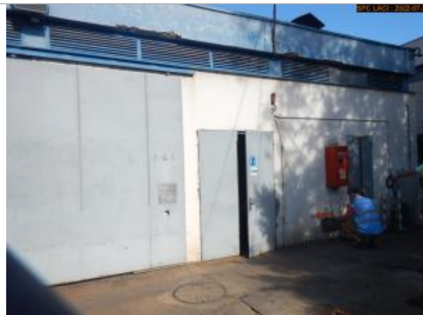
Vue du site éloignée (Bâtiment)
