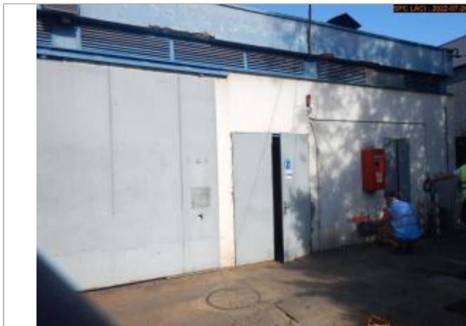
Vue du site éloignée (Bâtiment)
