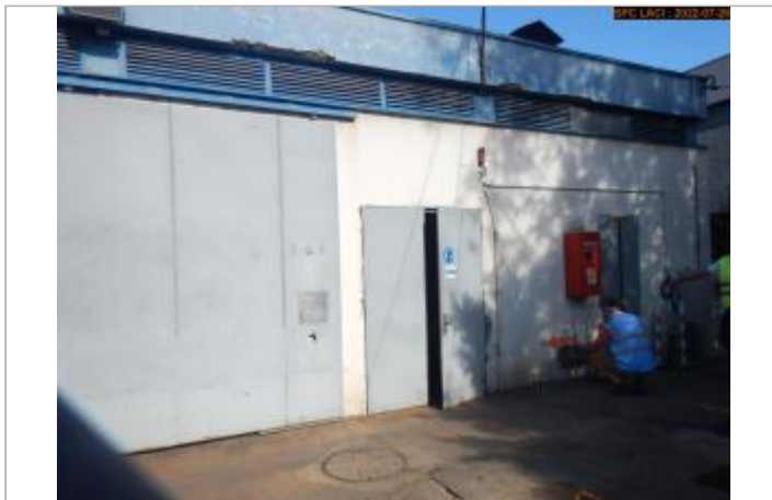
Vue du site éloignée (Bâtiment)
