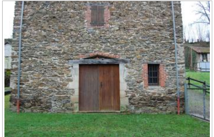
Vue du site - Auteur : GEOSPHAIR
