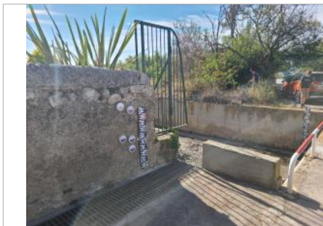
Repères posés sur le mur en rive gauche
