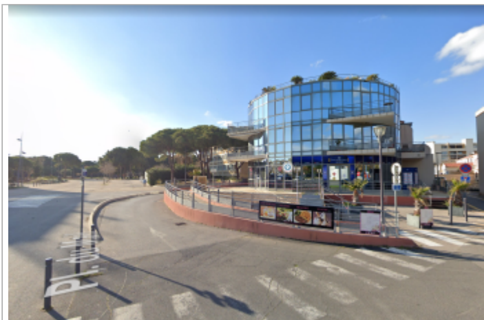
La grille d'évacuation des eaux est située sous le muret de la rampe d'accès
