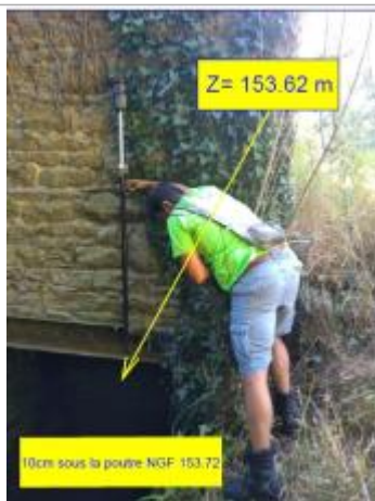
Poutre métallique du bras du moulin en 2022
