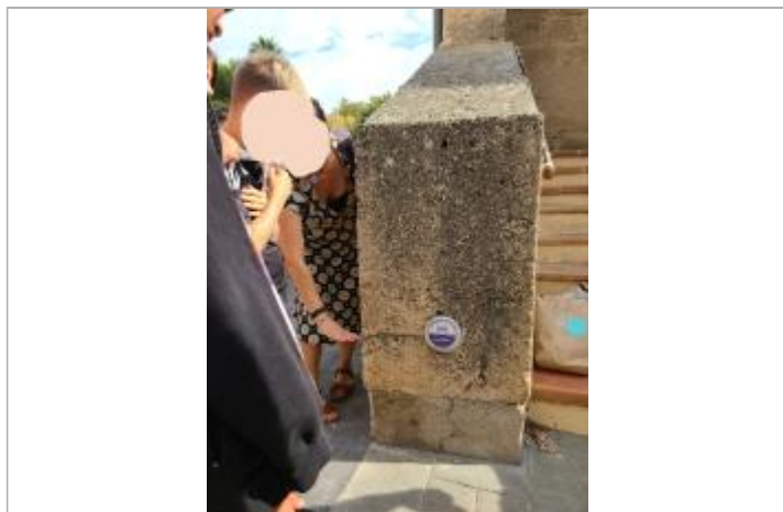
Pose du repère sur l'escalier
