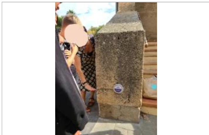
Pose du repère sur l'escalier
