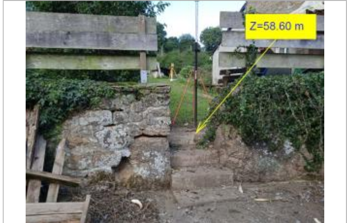
Marches donnant dans la cour et repérage nivellement
