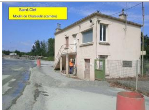
Bâtiment de la carrière proche du Trieux
