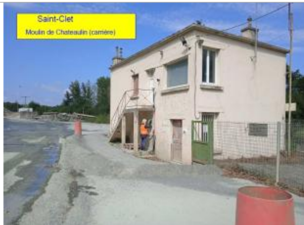
Bâtiment de la carrière proche du Trieux
